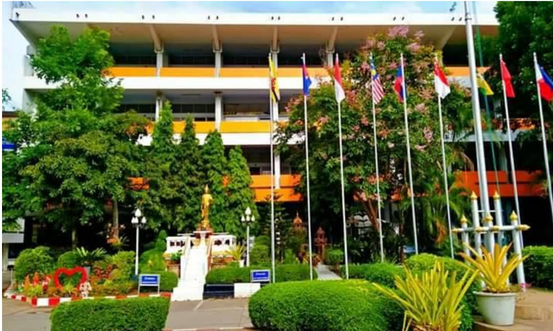
อาคารสามัญสัมพันธ์ คหกรรม และสาขาวิชาโลจิสติกส์ เป็นอาคารคอนกรีตเสริมเหล็ก 4 ชั้น มีเนื้อที่ 1,080 ตารางเมตร ก่อสร้างเมื่อปี พ.ศ.2530 งบประมาณ 5,440,000 บาท
